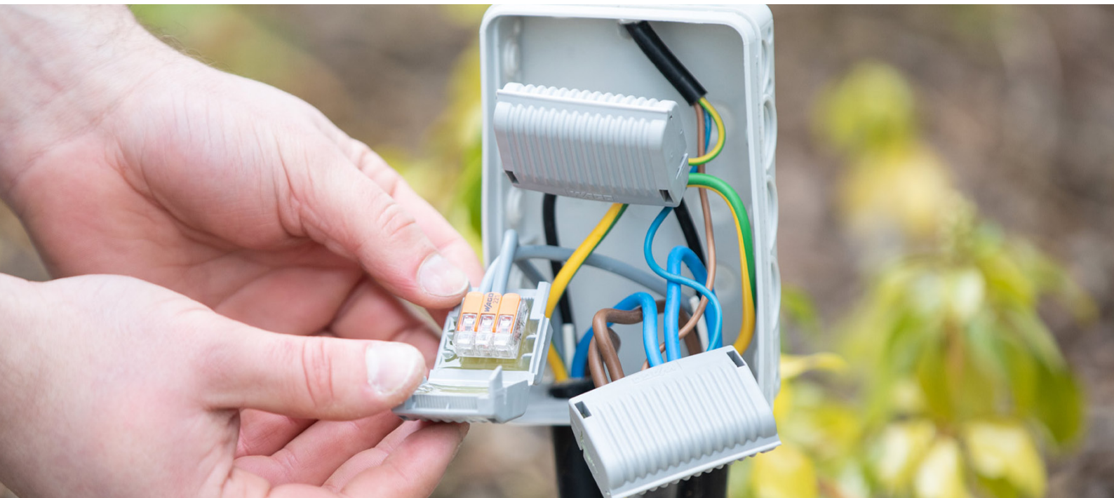
Extension des circuits : Ouvrez la Gelbox et retirez le gel du terminal. Ouvrez le terminal et montez le câble avec les nouveaux composants.
