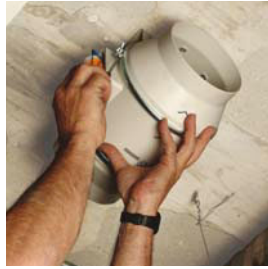
Insérer le corps moteur-hélice.
