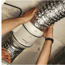
Raccorder les conduits.
