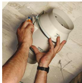
Insérer le corps moteur-hélice.
