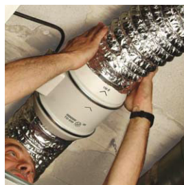
Raccorder les conduits.
